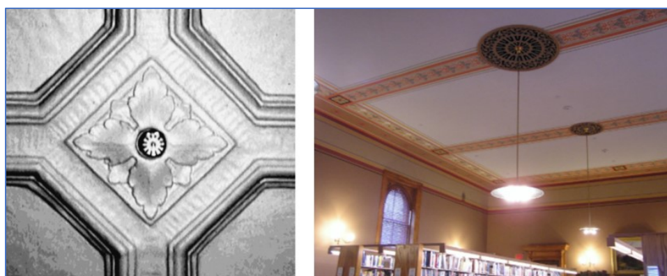
شکل ۱-۴: استفاده از نازل‌های ظریف برای شبکه بارنده خودکار برای جلوگیری از ایجاد آشفستگی بصری در ساختمان تاریخی
