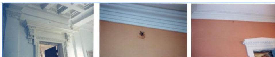
شکل ۱-۵: جانمایی نازل‌های شبکه بارنده خودکار به نحوی که با جزئیات هنری فضا همچون گچ‌بری‌ها، نقاشی‌ها و سایر تزئینات تداخل نداشته باشد
