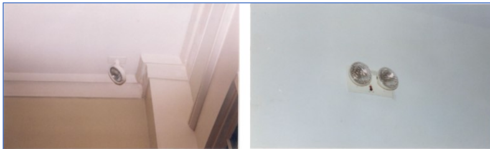
شکل ۱-۲: استفاده از چراغ‌های نورپردازی اضطراری دارای کمترین اثر بصری در محیط
